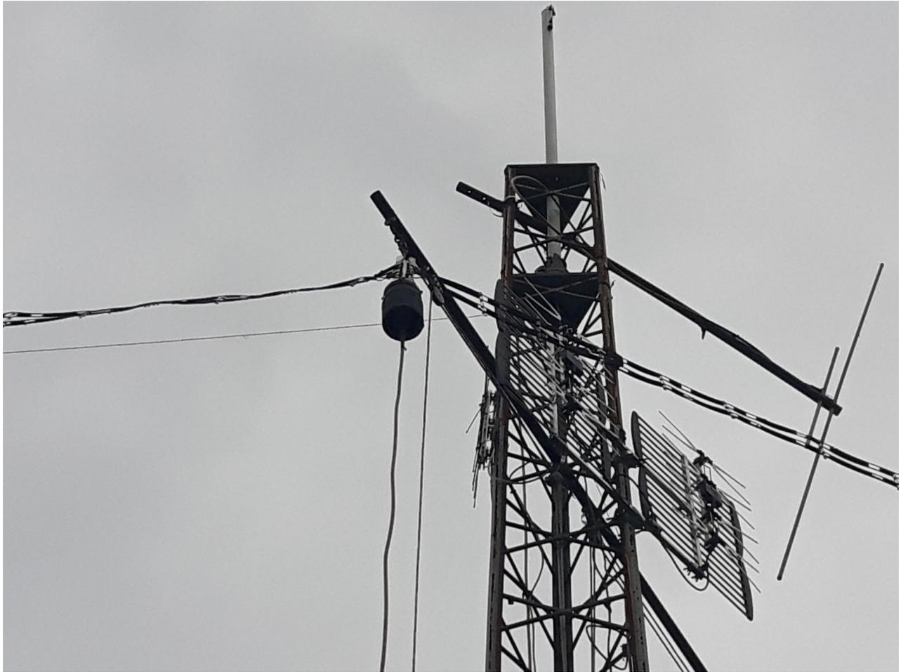
Antenne montée sous la poulie externe de la barre transversale. La corde passe par la poulie externe et ensuite par la poulie au centre de la tour et vers le sol. La corde est attachée au bas de la tour pour retenir l'antenne en haut de la tour.
